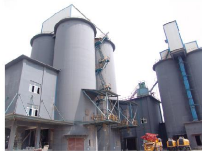
武汉生产厂是公司目前产能最大、现代化程度最高的生产厂,该厂建立于 2002 年,2009 年实施工艺改造。与传统磨机相比,立磨生产线有电耗低、系统磨损小、粉尘排放量少、自动化程度高等优点。这是公司在节能环保方面的努力之一。
